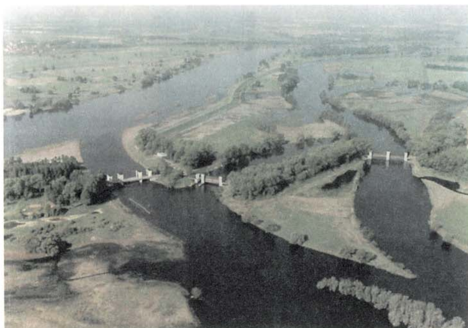
Soustava jezů v blízkosti obce Quitzöbel u soutoku Labe s Havolou - manipulovatelný jez Neuwerben (vlevo) slouží k odtoku vysokých kulminačních průtoků Labe do dolního toku Havoly - až 250 mil. m 3 (A. Prange)
