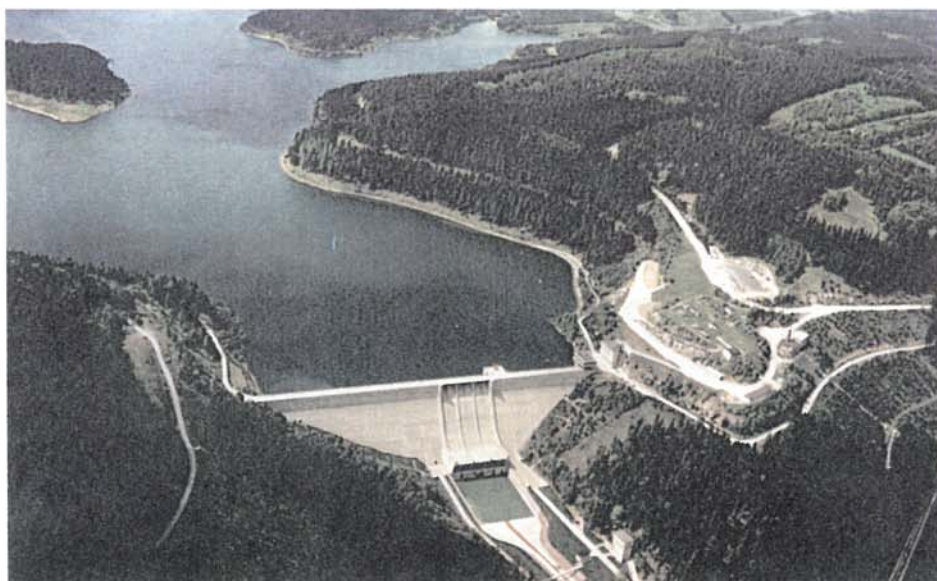
Vodní dílo Eibenstock v Krušných horách na řece Zwickauer Mulde - celkový objem 74,65 mil. m 3 a ovladatelný ochranný objem 3,25 mil. m 3 (Landestalsperrenverwaltung des Freistaates Sachsen)
