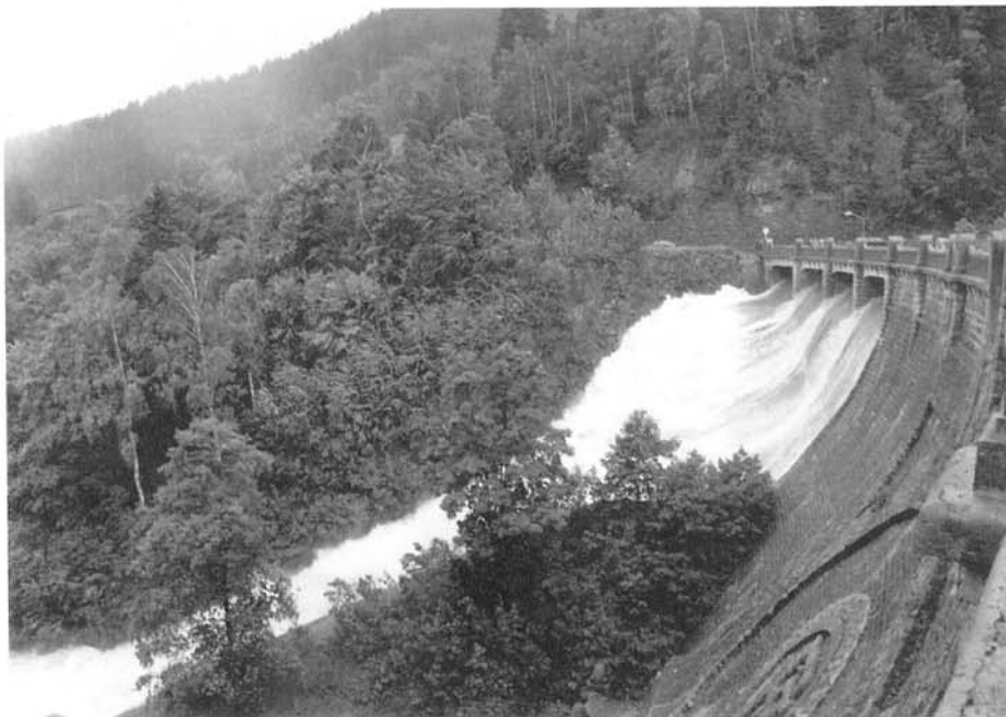
Vodní dílo Labská ve Špindlerově Mlýně - celkový objem 3,0 mil. m 3 , z toho 1,1 mil. m 3 ovladatelného ochranného objemu - přepad při povodni dne 7. 7. 1997 (Z. Šámalová)
