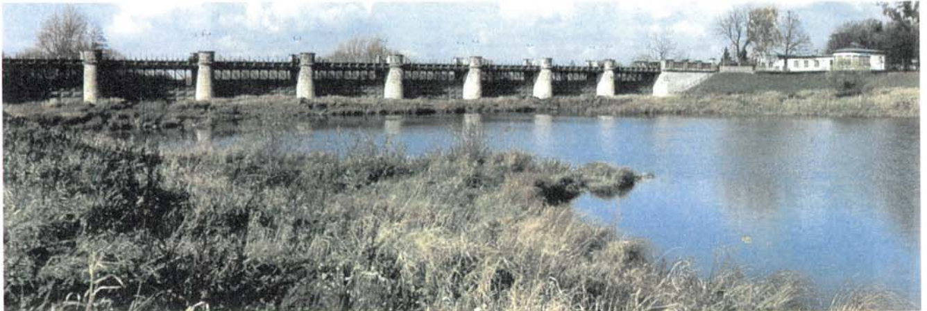
Jez Pretzien - při větších povodních se obtokovým kanálem u obce Barby v délce 29 km odvádí kolem Magdeburku až 20 % kulminačního průtoku Labe (K. Wecke)
