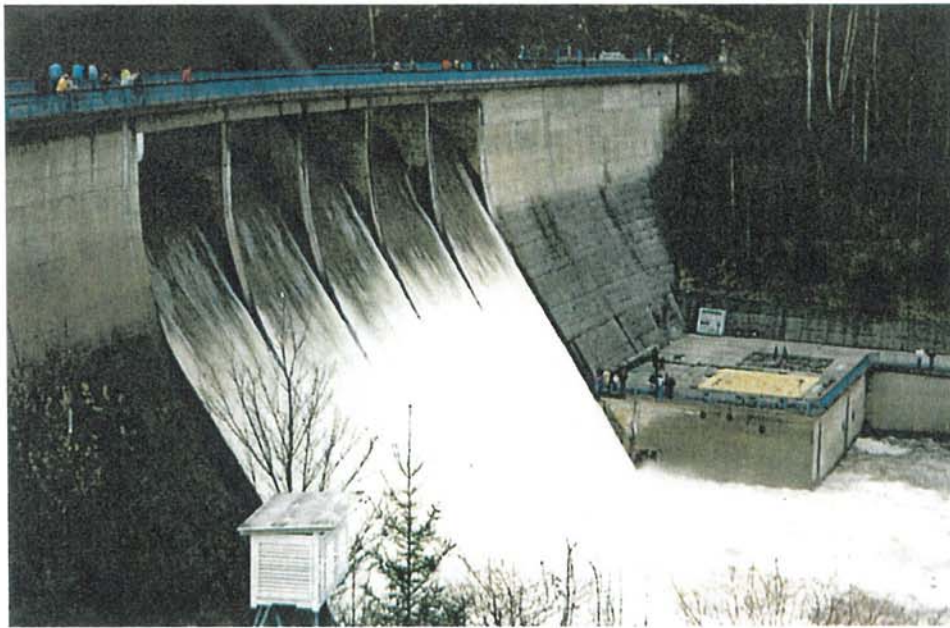
Přepad vodního díla Wendefurt na řece Bode v Harcu dne 13. 4. 1994 - díky retenčnímu účinku soustavy přehrad ve východním Harcu byl kulminační přítok Bode ve výši 190 m 3 /s na vodním díle Wendefurt snížena na 90 m 3 /s (B. Weigelt)
