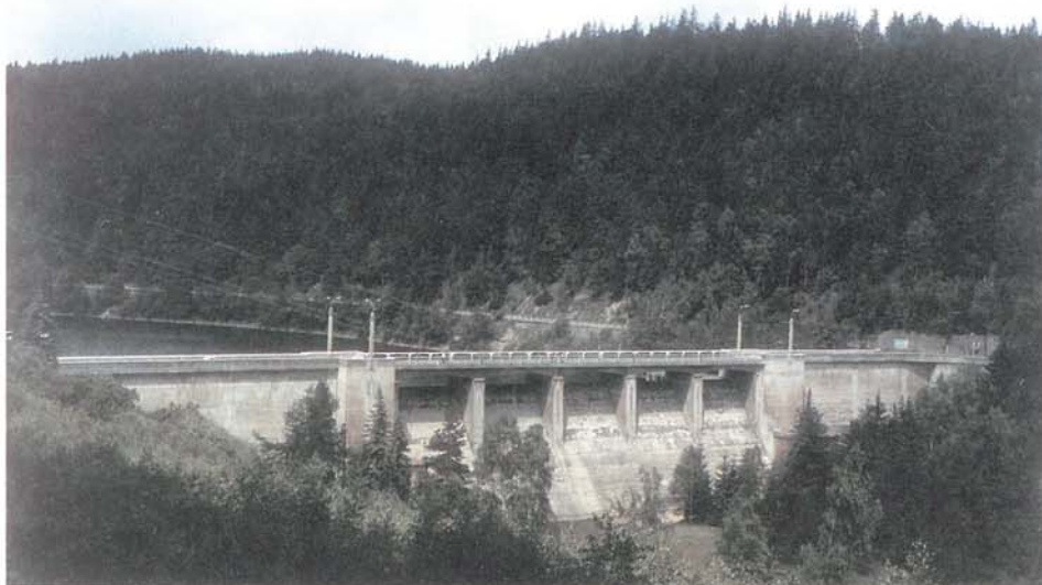
Vodní dílo Březová na Teplé u Karlových Varů v povodí Ohře s ovladatelným ochranným objemem 3,3 mil. m 3 (Povodí Ohře, a. s.)
