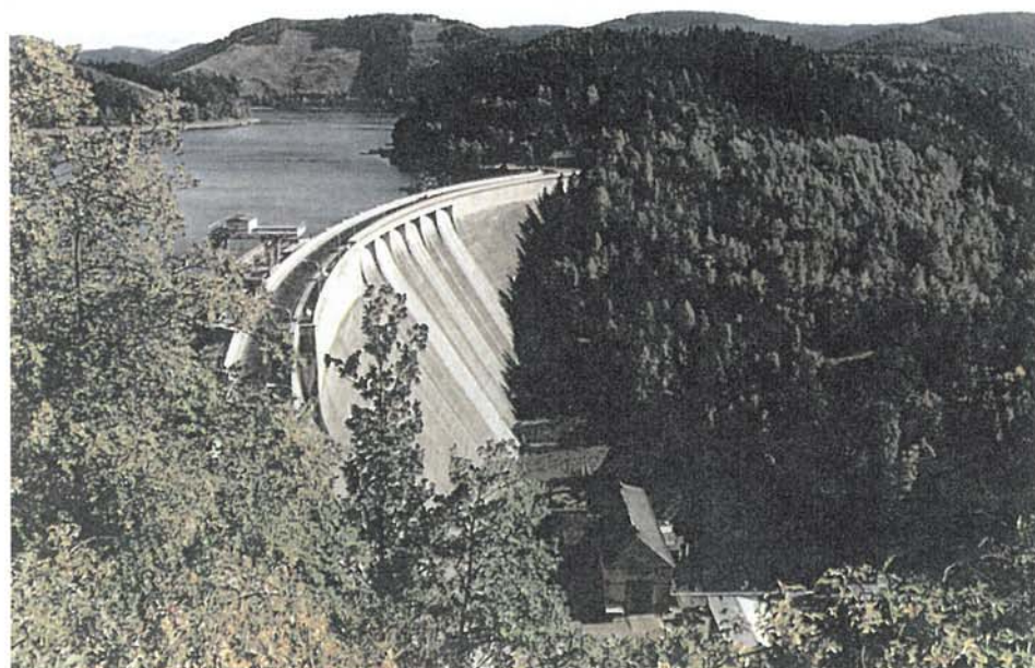
Vodní dílo Hohenwarte na Sáale s celkovým objemem 182,0 mil. m 3 má spolu s vodním dílem Bleiloch (215,0 mil. m 3 ), které je nad přehradou Hohenwarte, podstatný vliv na průběh povodní na Sáale - v zimním pololetí se obě vodní nádrže manipulují na volný ovladatelný ochranný objem 40,0 mil. m 3 . (Foto-König, Lobenstein)
