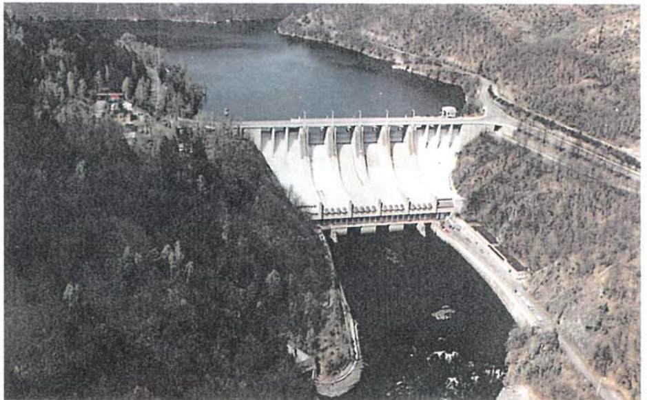
Vodní dílo Slapy na Vltavě s celkovým objemem 269,3 mil. m 3 a ovladatelným ochranným objemem 17,1 mil. m 3 (A. Prange)
