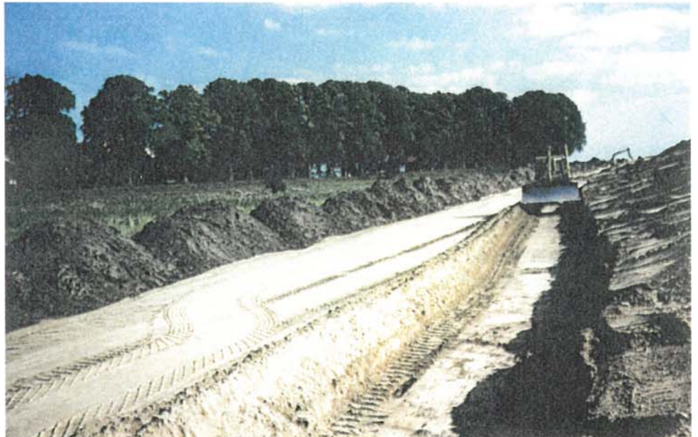
Práce k zesílení hráze na Labi v Meklenbursku - Předních Pomořanech - hráze jsou zvyšovány zásadně po stávající trase až o 70 cm při současném posílení jejich profilu (archiv)
