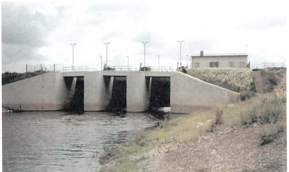
Jez Pretzien - při větších povodních se obtokovým kanálem u obce Barby v délce 29 km odvádí kolem Magdeburku až 20 % kulminačního průtoku Labe (K. Wecke)
