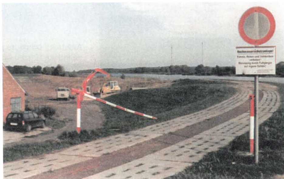
Asanační práce na labské hrázi u obce Wootz (Archiv Landesumweltamt Brandenburg)
