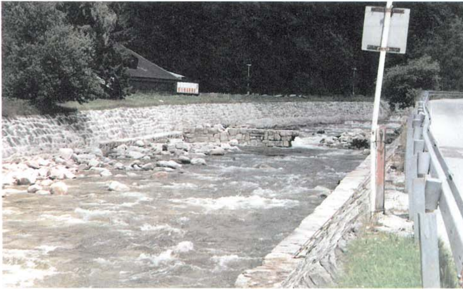
Stupně na Labi zničené ve Špindle- rově Mlýně při po- vodni v červenci 1997 (Z. Šámalová)
