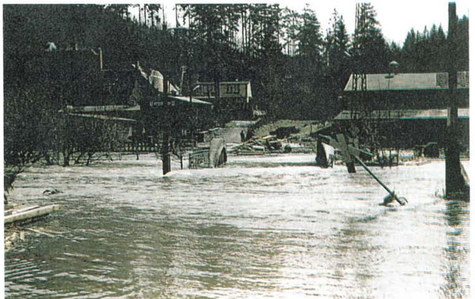
Zatopení železniční tratě a silničního mostu říčkou Selke v obci Silberhütte v Harcu, duben 1994 (S. Ellermann)
