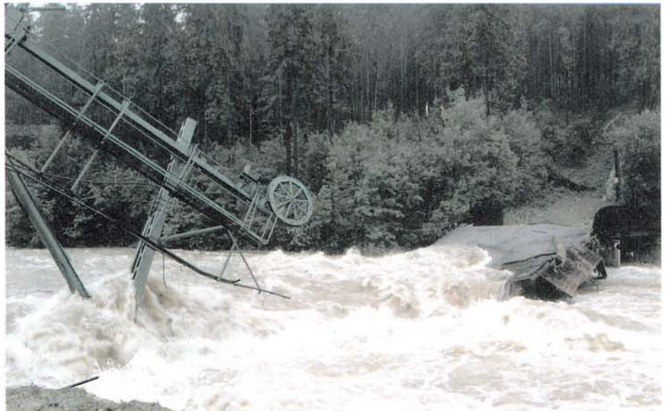
Zničený most a po- škozený lyžařský vlek na Labi ve Špindlerově Mlýně při povodni v čer- venci 1997 (Z. Šámalová)
