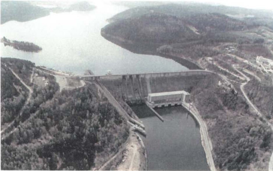
Vodní dílo Orlík na Vltavě je s celkovým objemem 716,5 mil. m 3 a ovladatelným ochranným objemem 62,0 mil. m 3 klíčovým vodním dílem Vltavské kaskády (A. Prange)
